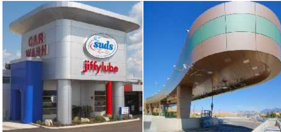
Figura 15. Paneles sándwich en fachadas de edificios.
