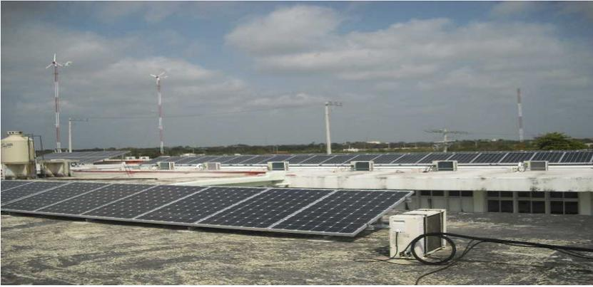
Figura 2.16.- Sistema de generación de energía fotovoltaica de 22 kW
