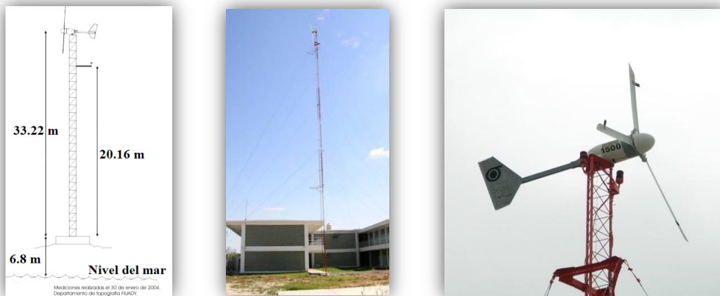
Figura 24. Aerogenerador Bergey de 1.5 KW: (izquierda) diagrama de instalación, (centro) vista general de la torre de instalación y (derecha) vista del aerogenerador.
