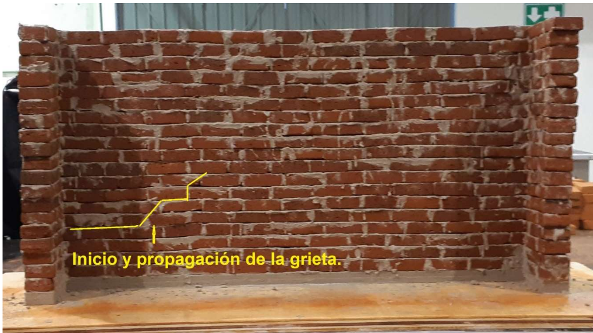
Figura 4.15 Muro de bloques de ladrillos de barro después de la prueba en mesa sísmica.
