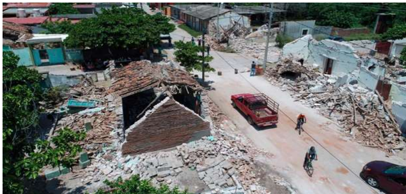
Figura 1.3 Daños en viviendas ocasionados por el sismo de Oaxaca en 2017 [11].
