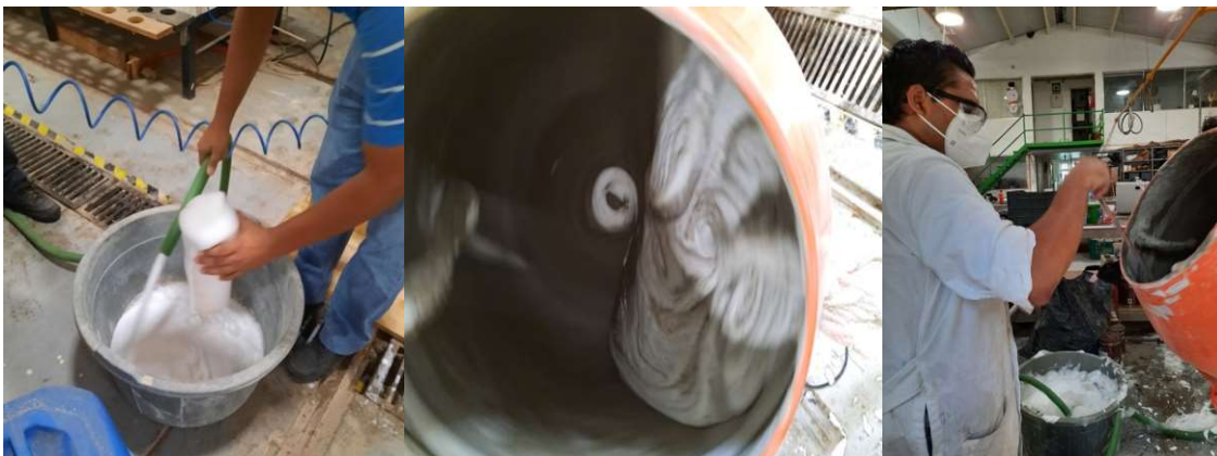
Figura 3.2 Elaboración de la mezcla de concreto espumado para la fabricación de los muros
