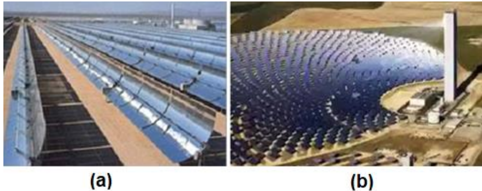
Figura 1.4. Calentadores solares de alta temperatura (a) Sistema de colectores parabólicos; (b) Sistema de heliostatos para generación de energía eléctrica.
