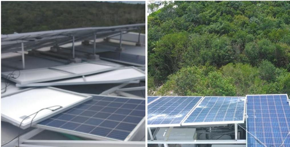
**Figura 2.12** Sistema FV averiado por la tormenta tropical “Gamma” en Akumal, Quintana Roo. En su estado inicial los módulos FV serán caracterizados con mapas de EL y termografía. Para ello, es necesario alcanzar el voltaje de circuito abierto y la corriente de corto circuito de estos módulos FV. Estos datos se localizan en la parte trasera de los mismos.
