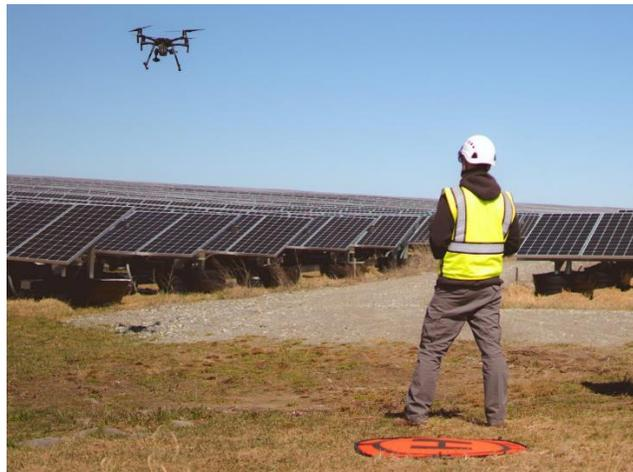
**Figura 1.13** Inspección termográfica aérea en planta FV (imagen: Raptor Maps).
