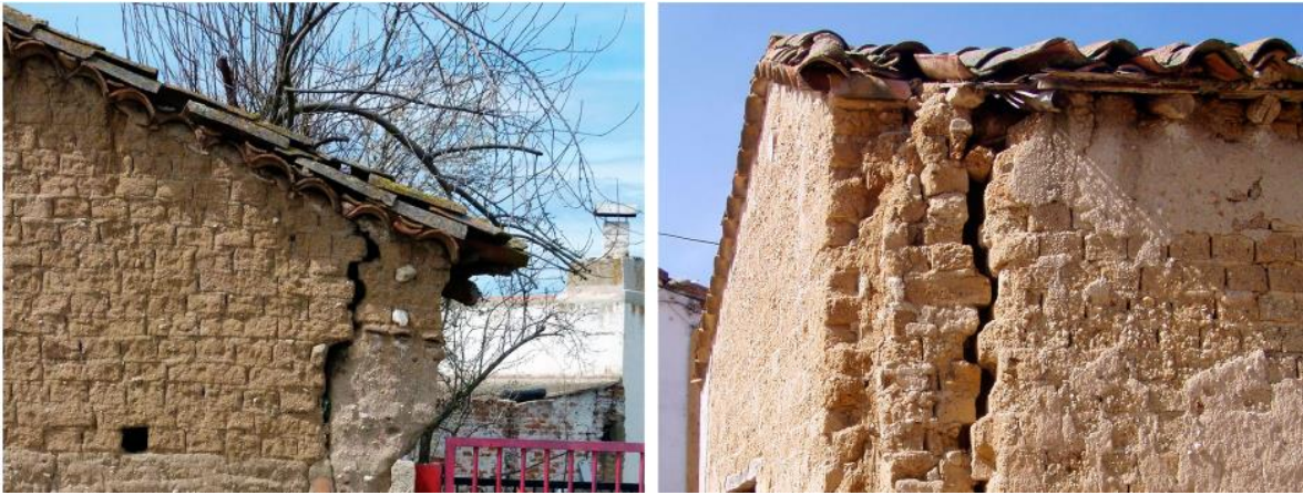
Figura 1.15.- Daño significativo en materiales de adobe debido a la meteorización [33].
