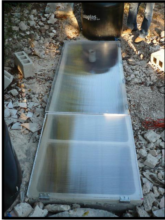
Figura 2.6. Láminas de policarbonato instaladas en la fosa séptica convencional.
