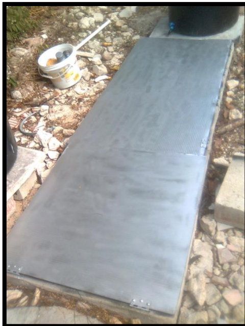
Figura 2.7. Láminas de fosa séptica convencional pintadas.
