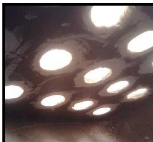
Figura 2.14. Aplicación de sellador a la cámara de las CCM
