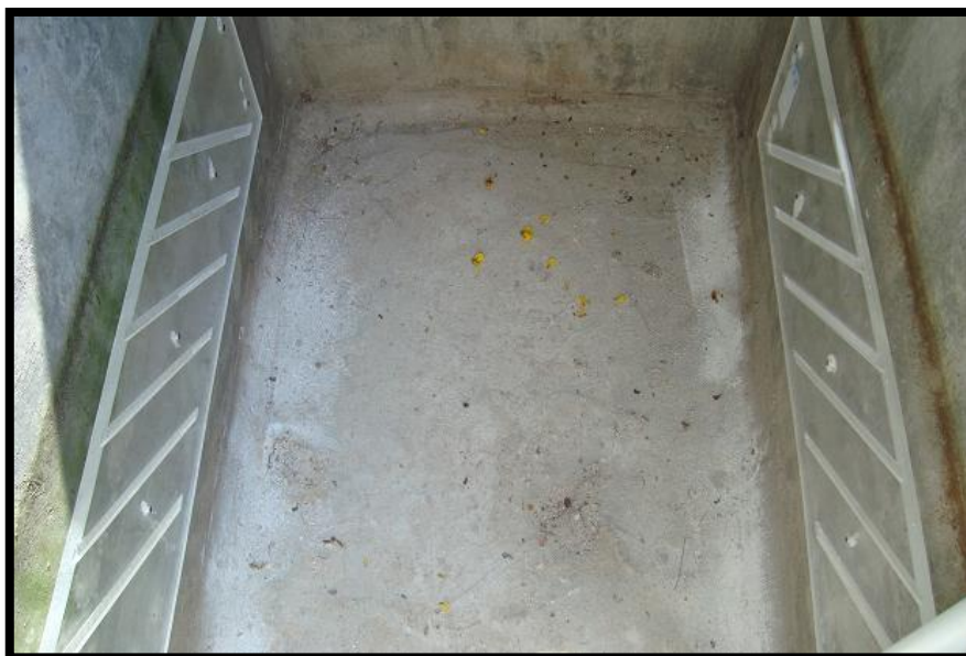
Figura 2.8. Placas soporte del SAT instaladas en la fosa séptica convencional.
