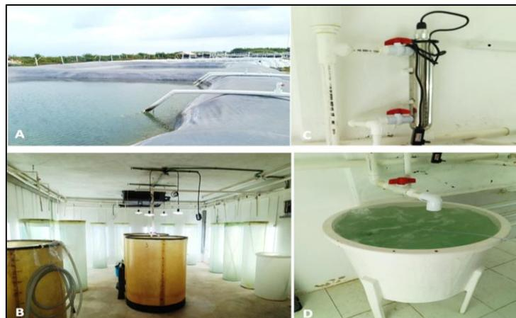
**Figura 2. 2.** A) Balsas de depósito de agua que proviene del sistema marino, B) Cuarto de cultivo, C) Tratamiento con UV de agua marina y D) Depósito de agua con tratamientos de cloración y filtrado que se utiliza en los cultivos.
