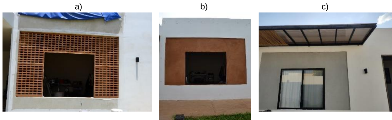
Figura 2.1 Muro híbrido propuesto: muro de carga (parte del muro pintada en color blanco), y muro no estructural en su a) entramado de madera en forma de malla, b) rellenado con el material a base de pak'luum y capa de acabado, y c) pintado en color gris y con un alero que lo protege.
