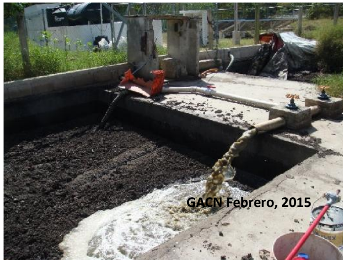
Fig. 2.3. Cárcamo recolector de agua residual generada en la Unidad Porcícola del Campus de Ciencias Biológicas y Agropecuarias, de la Universidad Autónoma de Yucatán.
