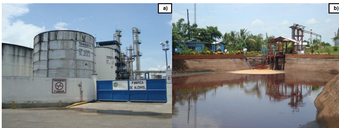
Figura 2.1. Instalaciones del ingenio “La Gloria”: a) Planta de producción de etanol hidratado, b) Recepción y almacenamiento de vinazas
