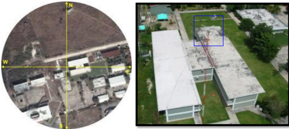
Figura 2.4. (Izquierda) Plano de 300 m x 300 m del sitio de operación del aerogenerador Bergey BWC-1500; (Derecha) imagen del aerogenerador en el sitio de operación.
