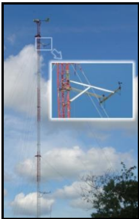
Figura 2.9. Torre del aerogenerador: estación anemométrica a 30 m de altura con sus respectivos sensores de velocidad, dirección, temperatura.
